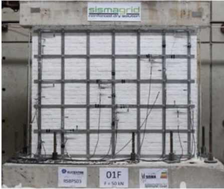
Griglia in acciaio ancorata alla muratura
