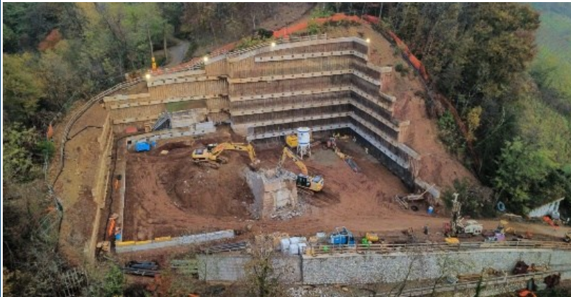
NUOVO SERBATOIO DI ACQUEDOTTO INTERCOMUNALE DI BERGAMO
